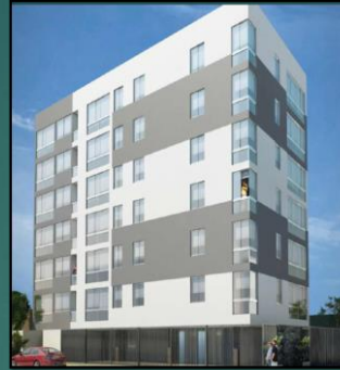
EDIFICIO TRIANA SAN MIGUEL
